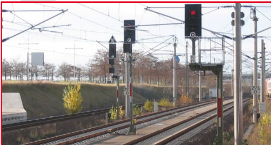
Drei Mastvarianten auf einen Blick. Während rechts der lange Ausleger und links der kurze Ausleger zu sehen sind, konnte beim mittleren Signal wegen der engen Gleislage nur der gerade Mast verbaut werden.
