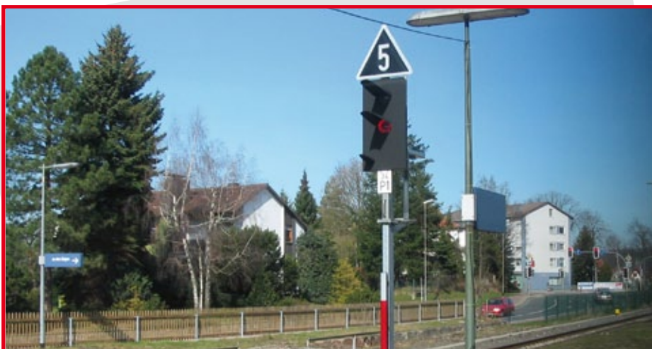
Inzwischen gibt es neben der Normkonstruktion, die bis auf die andere Lampenanordnung den H/V-Kompacktsignalen entspricht, auch einfache Bauarten für preiswerte Nebenstreckenprojekte.
