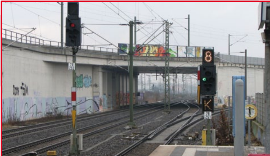
Ks-Signal in Standard- und Zwergausführung. Der gelbe Pfeil weist darauf hin, daß diese Signale auch eine Vorsignalfunktion aufweisen. Der Richtungsanzeiger Zs 2 am rechten Signal zeigt den Fahrweg „K“ an, dessen Bedeutung der Lokführer in den örtlichen Richtlinien nachlesen kann
