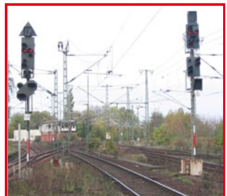
Kompaktsignal (rechts) im direkten Vergleich zur Bauart 1969 (links). Die augenfälligsten Unterschiede sind die Integration des Ersatz-/Vorsignals in den Hauptsignalschirm, die rechteckige Form des Vorsignals mit integriertem Zusatzlicht für verkürzten Bremsweg und der Entfall der Dreieckblende beim Zs 3.
