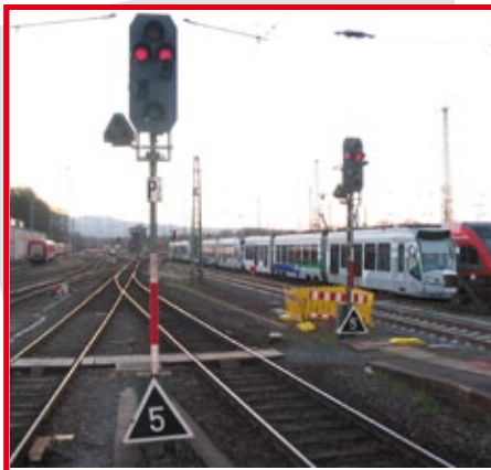
Hauptsignal Bauart 1951 in der Ausführung als Ausfahr-/Zwischensignal in der Ursprungsausführung mit seitlich versetztem Ersatzsignal, mit Doppelrot und in den Schirm integrierten Optiken für das Rangiersignal Sh 1.
